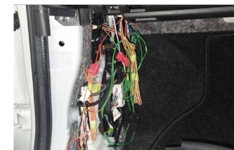
⑯助手席キックパネル内から延長配線を引き込み、ページ1の配線説明を参考に電源の取り出しを行います。
