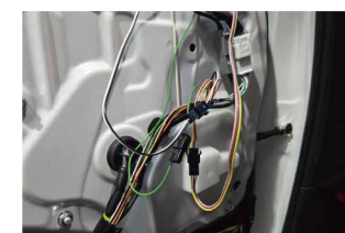
⑱電源の取り出しが終わったら製品の配線と延長配線を接続します。
