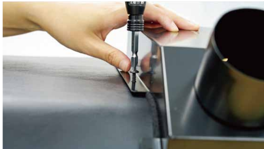
④ヒーターダクト本体を設置し、 付属のタッピングネジで固定します。
