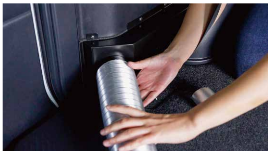
⑥フレキダクトを取り付けます。
